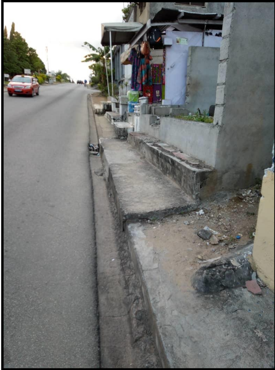
Photo 13 : Vue du côté est de la cité donnant sur la voie allant vers la cité Allabra, secteur riviera 2 (Source : Nos enquêtes 2019)
