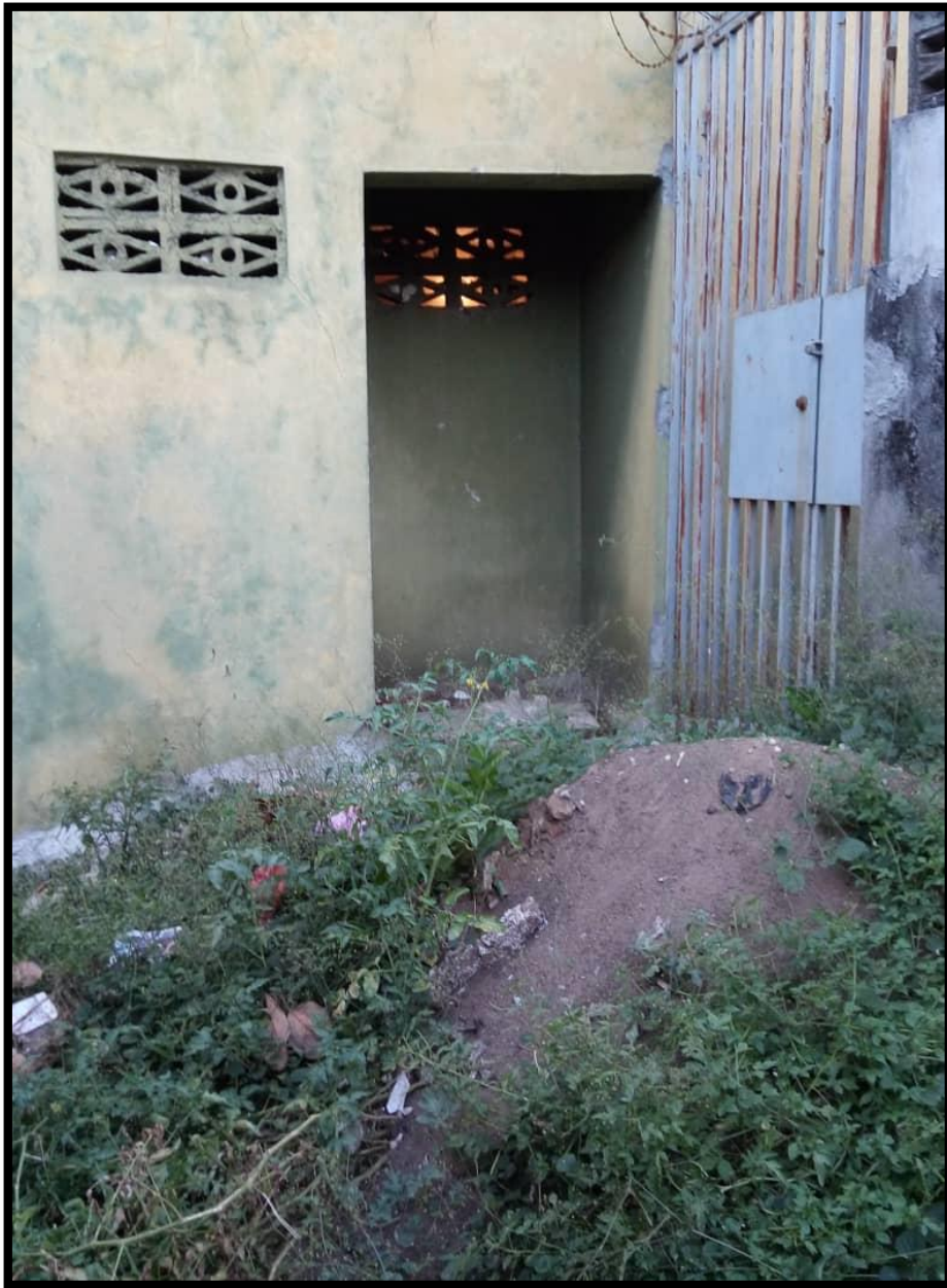
Photo 6: Vue d'un couloir fermé par une guérite, secteur riviera 2 (Source : Nos enquêtes 2019)
